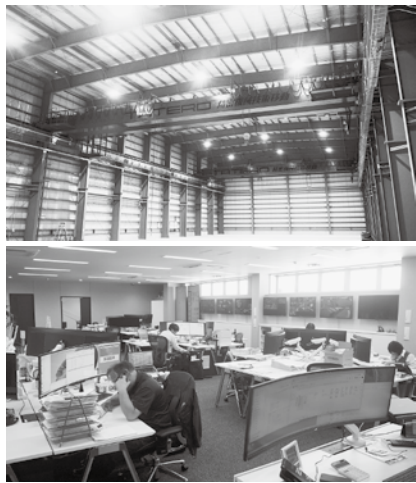
重量物専用倉庫（上）と事務所内
